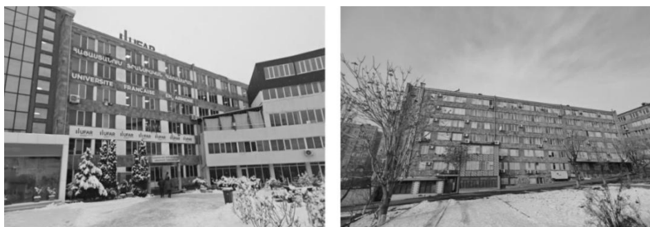
Рис. 2. Здание с главного и заднего фасадов /
