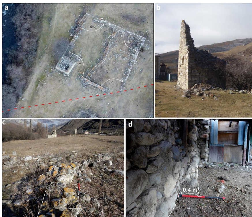
Рис. 7. Сейсмотектонические деформации построек древнего селения Даллагкау (Барзикау). а – план башни Есиевых и прилегающей постройки, б – общий вид башни Есиевых с севера, с – винтообразные изгибы с разрывом сплошности внутренней стены здания, примыкающего к башне Есиевых, d – смещение стены в центральной части селения Даллагкау, т. 1 на рис. 6 / Fig. 7. Seismotectonic deformations of the buildings of the ancient settlement of Dallagkau (Barzikau). a – plan of the Yesiev Tower and adjacent building, b – general view of the Yesiev Tower from the north, c – spiral bends with a break in the integrity of the internal wall of the building adjacent to the Yesiev Tower, d – displacement of the wall in the central part of the Dallagkau settlement, point 1 in Fig. 6.
