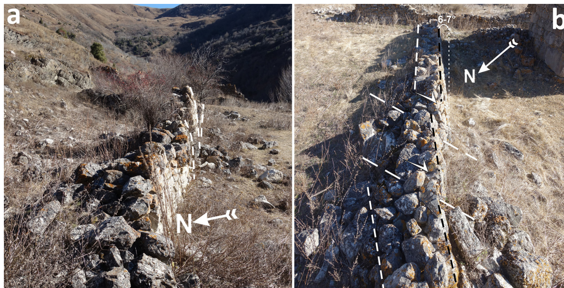
Рис. 5. Деформации стен ЗСЗ ориентировки. а – внешняя стена дома в СВ части селения, т. 9. Штриховыми линиями показаны смещенные фасы стен в бортах правосдвиговых разрывов, б – внешняя стена центрального комплекса сооружений, т. 4 /
