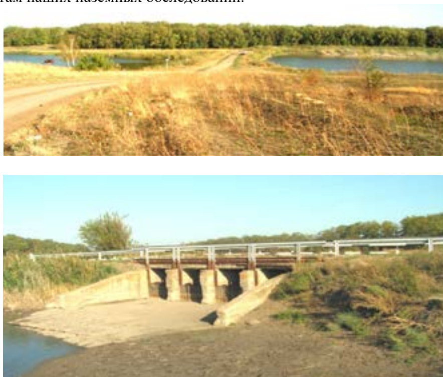
Рис. 3. Типичные русловые плотины на р. Ея – в виде земляной насыпи выше ст. Калниболотской (вверху), с автодорожным мостом в пос. Советский (внизу) /
