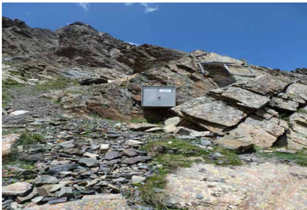
Рис. 2. Оборудование сейсмической станции «Колка»
