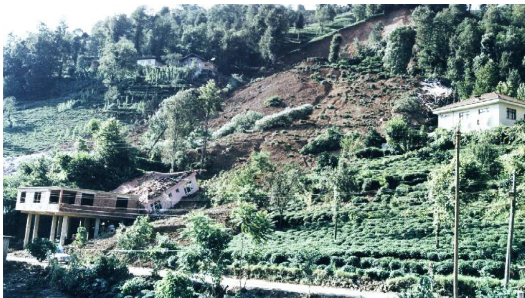
Рис. 12. Оползень в с. Селамет двигавшийся отдельными подвижками с высоты 30 м, разрушивший жилой дом (слева) и остановился, упершись в выступ вулканогенных пород (photo A. Uzun)
