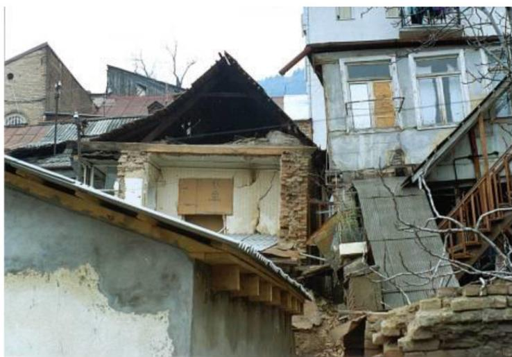
*Рис. 9. Тбилиси. Дом на ул. М. Зичи (повреждение 5 степени).*
