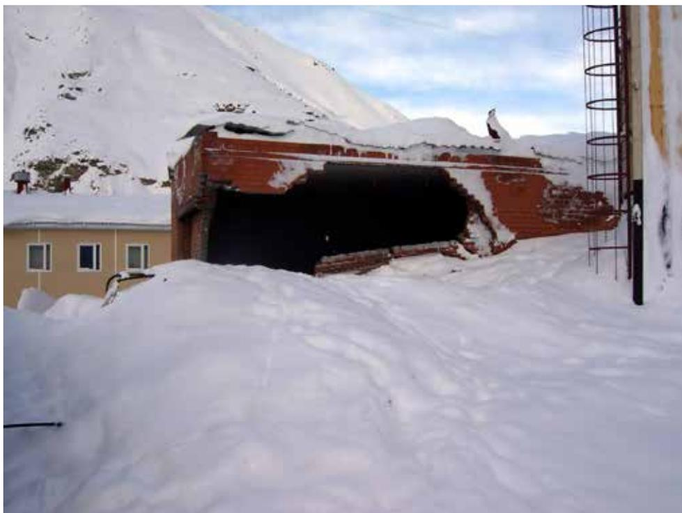
*Рис. 10. Разрушенная котельная военного городка Рокского тоннеля в январе 2013 г. (фото Шамиля Сулейманова)*
