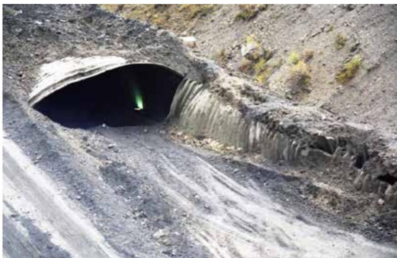
Рис. 8. Раздавленная лавиной противолавинная галерея из гофрированной стали. 2002 г.
