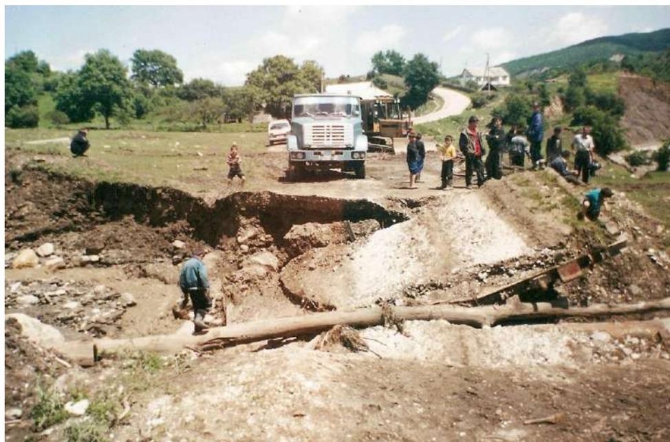
Рис. 1. Оползень, разрушивший автодорогу и возникший в результате Курчалойского землетрясения 11 октября 2008 г. с  $K_p = 14,5$ ,  $M_w = 5,8$ ,  $I_0 = 7-8$  [Гайсумов, 2014]
