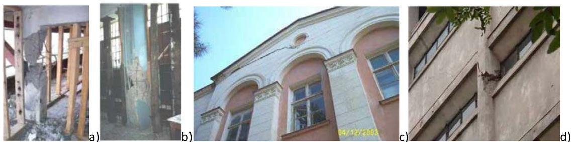
*Рис. 3. Повреждения зданий при Тбилисском землетрясении 25 апреля 2002 года: а) повреждение колонн здания Института математики; б) Колонна первого этажа ЖБ крупноблочного дома в Надзаладевском районе; с) кирпичное здание больницы по ул. А. Казбеги; d) поврежденная колонна здания Государственного исторического музея [Gabrichidze et al., 2004] /*
