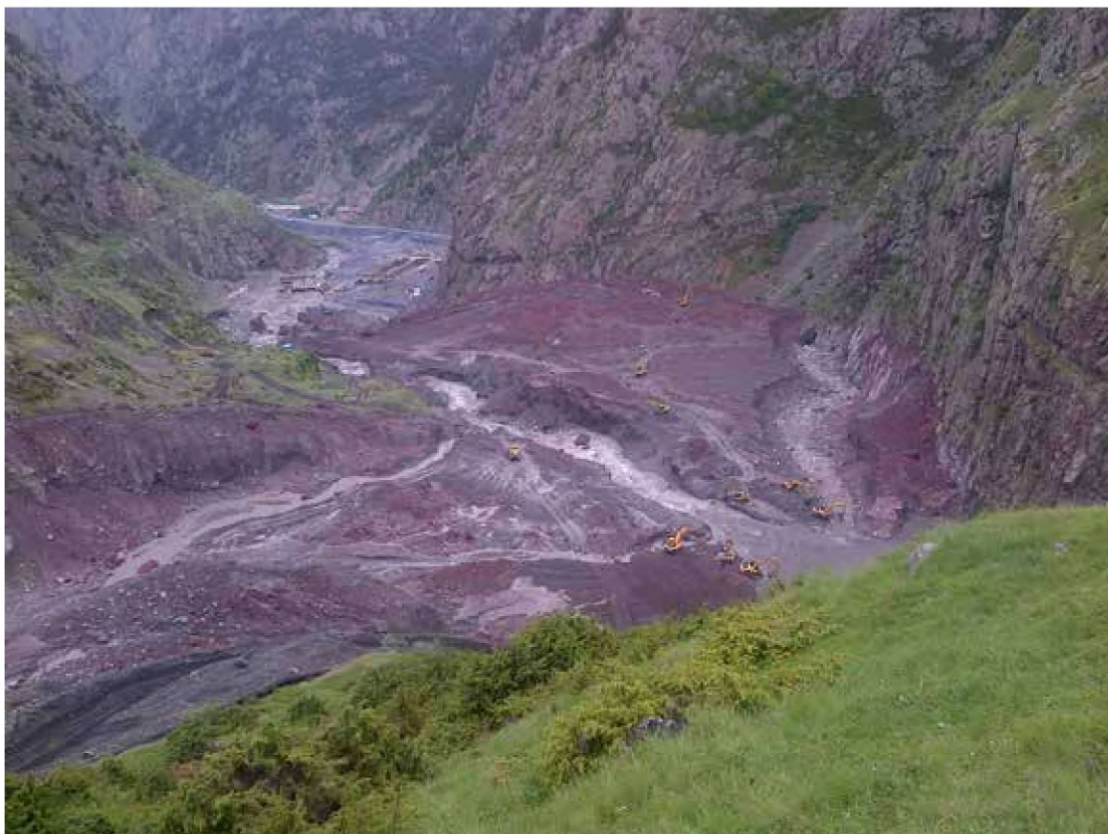
Рис. 3. Подпрудное озеро, работы по созданию нового русла. Фото Г. Гоциридзе
