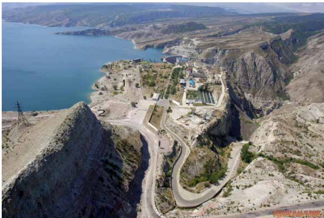
Рис. 1. Фото участка правого борта плотины Чиркейской ГЭС (цифрами 1 и 2 отмечены места расположения устьев скважин).
