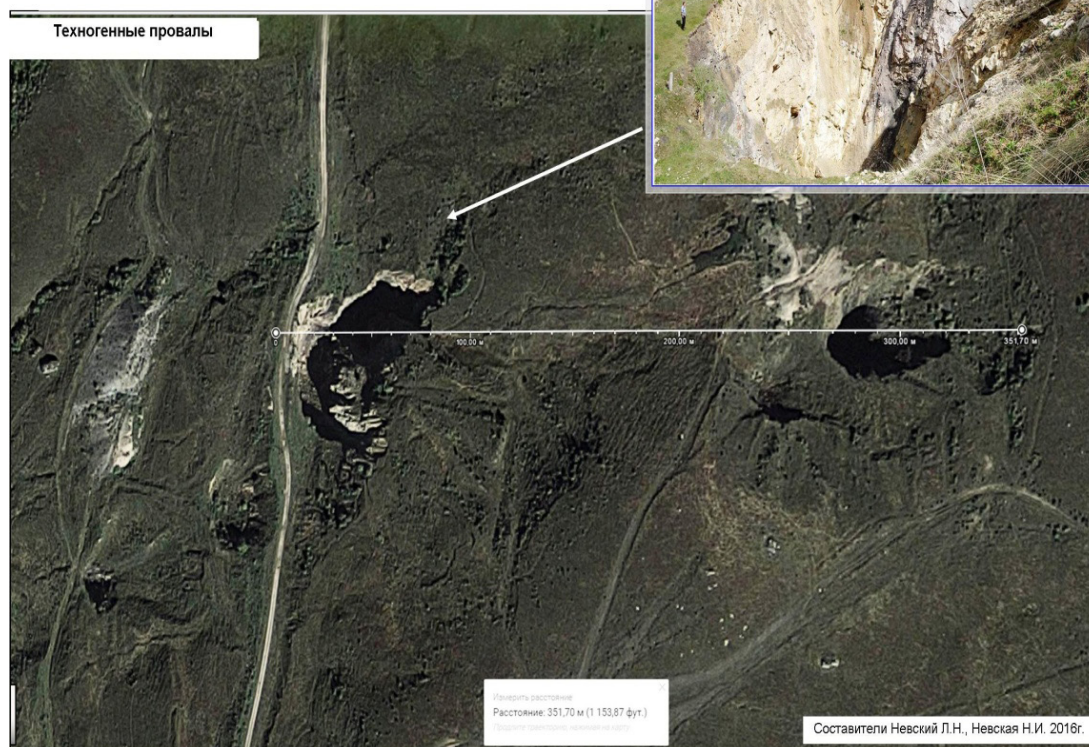
Рис. 2. Техногенные провалы над горными выработками Згидского месторождения
