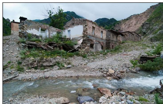
Бывшие жилые шахтерские дома, разрушенные селевым потоком.
