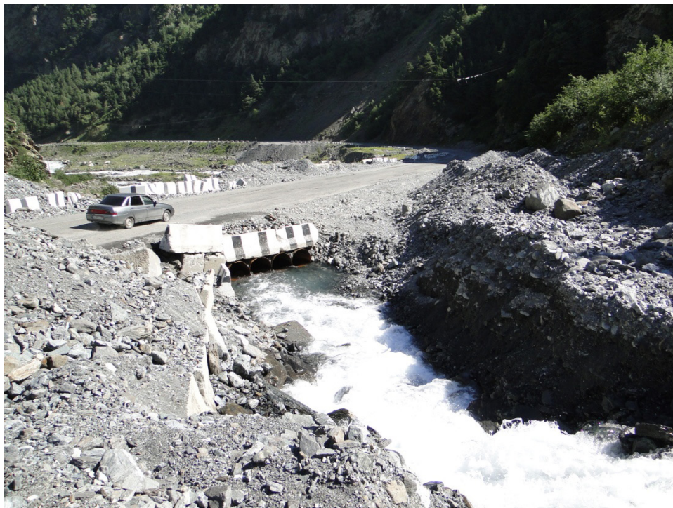
Рис. 3. Водопропуск на р. Касайкомдон (фото Р. Тавасиева)
