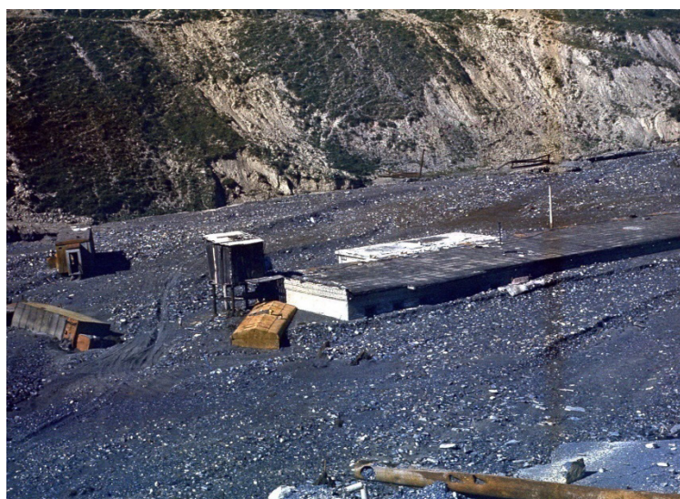
Рис. 13. Городок строителей Рокского тоннеля погребенный селем в 1987 г. (фото Р. Тавасиева)
