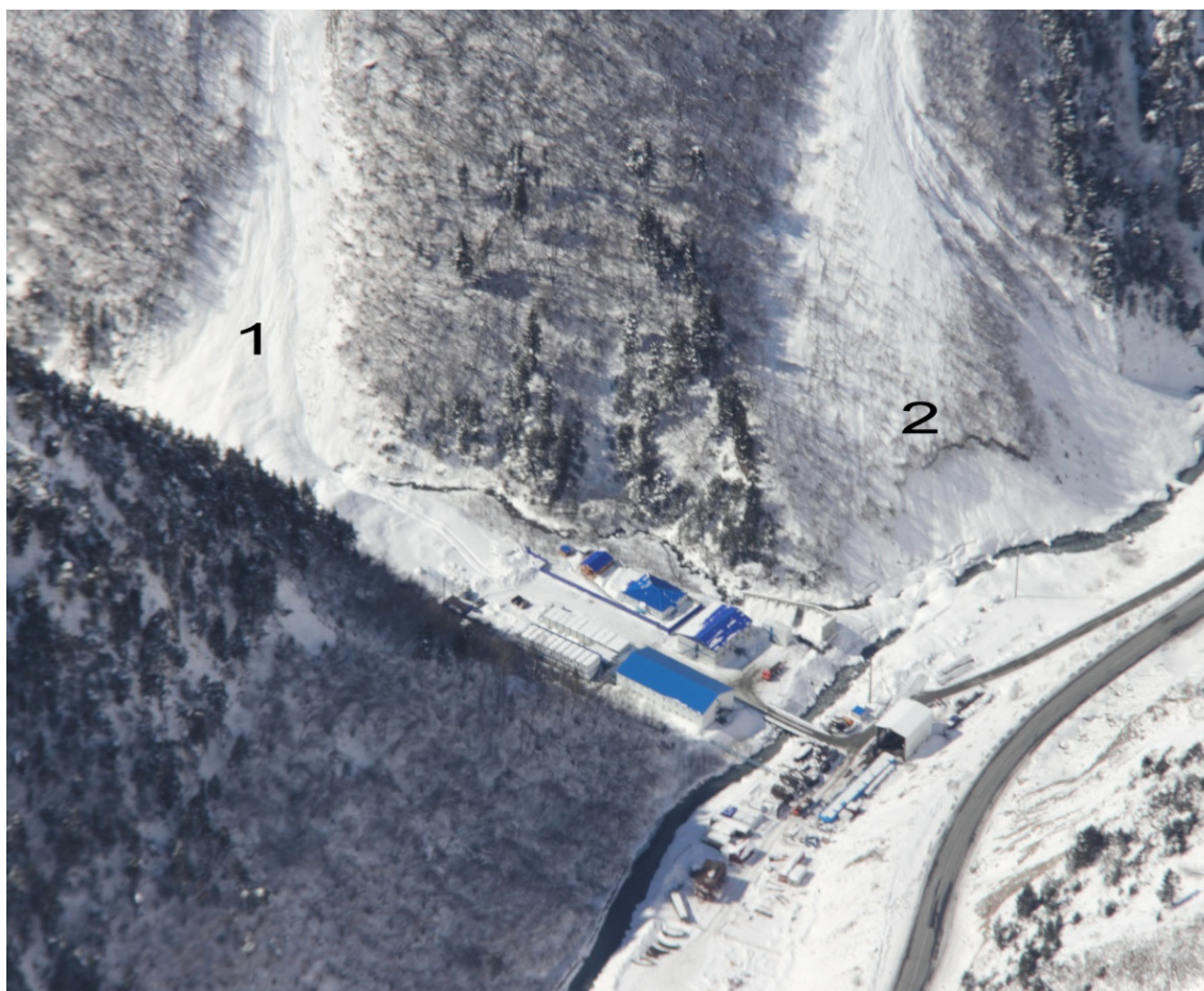
Рис. 15. Опасное размещение городка строителей в устье р. Гинат. Аэрофото МЧС
