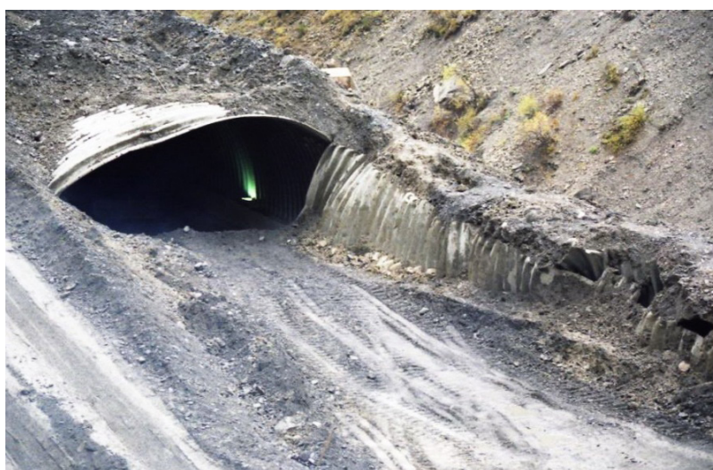
Рис. 8. Раздавленная лавиной противолавинная галерея из гофрированной стали. 2002 г.
