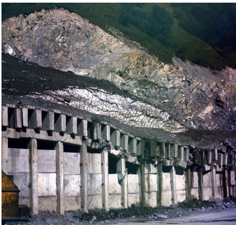
Рис. 7. Частично разрушенная лавиной противолавинная галерея. 1987 г. (фото Р. Тавасиева)
