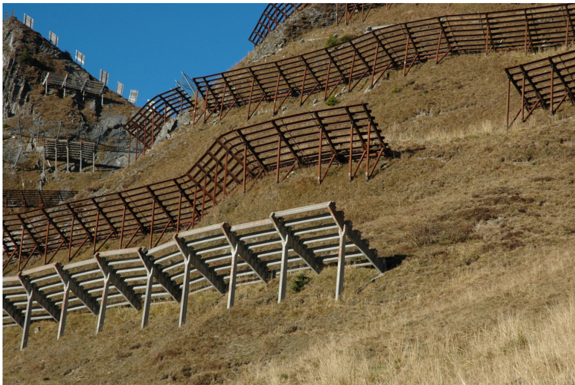
Рис. 14. Лавиноудерживающие щиты в Швейцарии (фото И. Галушкина)
