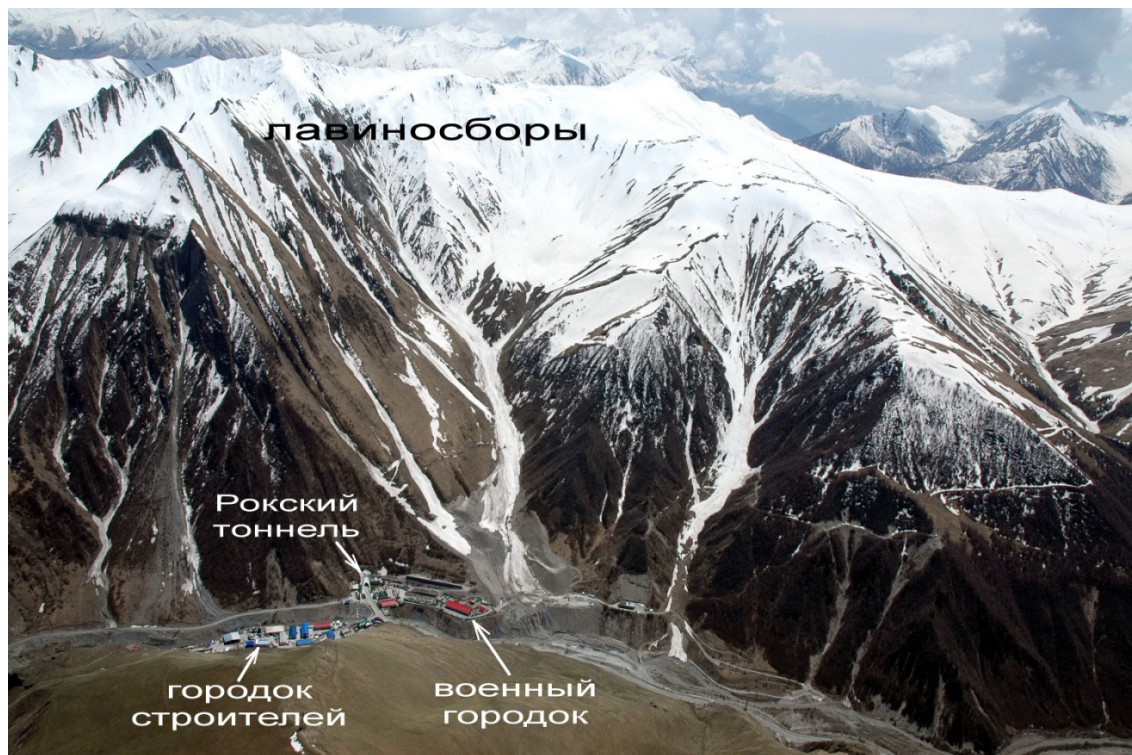
Рис. 9. Лавина Той и инфраструктура ТРАНСКАМ около Рокского тоннеля. Аэрофото МЧС.
