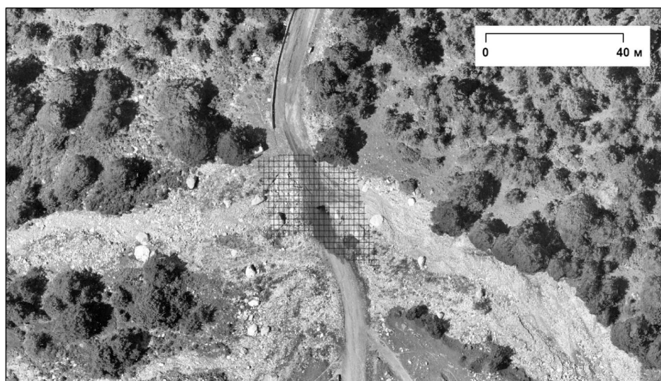
Рис. 4. Разрыв дороги селевым паводком 21 июля 2025 г. Область разрыва заштрихована /
