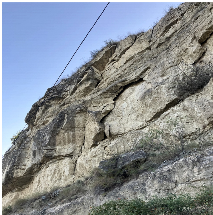
Рис. 3. Фото неустойчивого массива с вертикальными отрывными трещинами /
