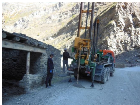
Рис. 3. Бурение скважин / Fig. 3. Drilling wells
